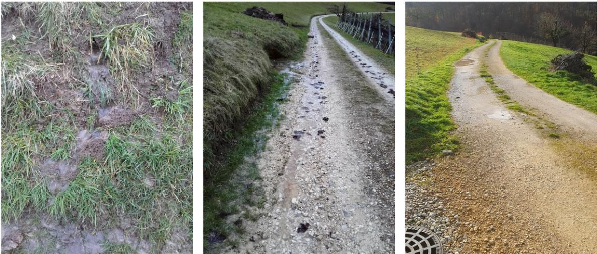
Die drei Drainageleitungen wurden zusammengefasst und als offener Bachlauf über zwei Parzellen und unter einer Strasse hindurch geführt. Der Bachlauf wurde am unteren Ende in das bestehende Rohrsystem eingeleitet. Die Zusammenführung der drei Drainagen sichert dem Bachlauf genügend Wasser auch in Trockenzeiten.
