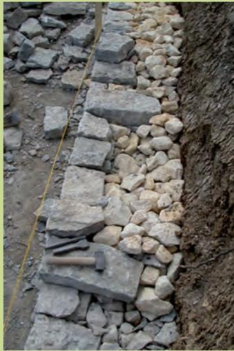
Die Bruchsteinmauer ist mit Schroppen hintermauert, welche direkt und ohne trennendes Vlies ans Erdreich grenzen. Grosse Steine verstärken als Binder den Zusammenhalt der Mauer.
