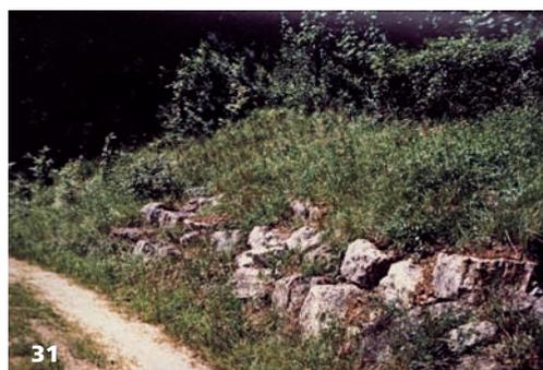
Abb. 31: Blockwurfmauer am östlichen Ende des Transektiv «Waldrand Leisele» (Klein et al. 1986b)
